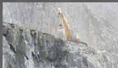
切羽での作業①
