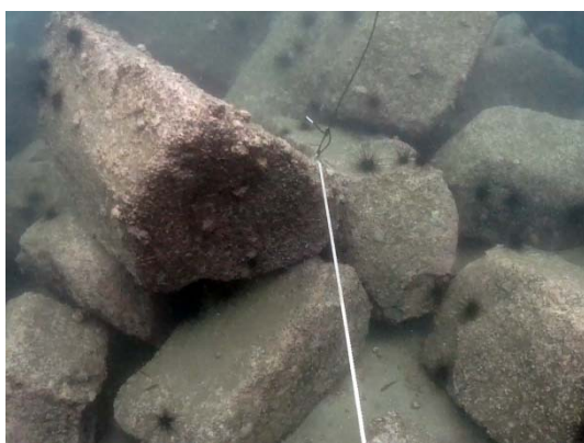
石材（中央付近、積重なり）
