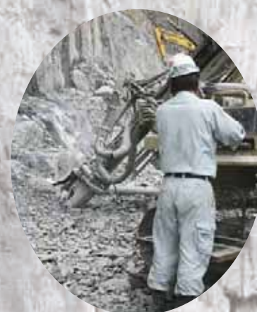
発破用穴開け作業
